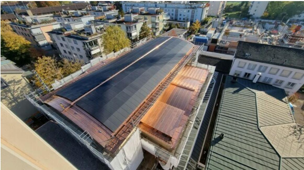
Die Solarpaneele wurden so angeordnet, dass sie die Gliederung des Kupferdachs mit seinen Stehfälzen nachzeichnen, und vom Dachrand zurückversetzt, damit sie von unten betrachtet nicht sichtbar sind. Das mattierte Kupfer wird in etwa einem halben Jahr oxidiert sein und sich auch farblich nahtlos integrieren. **Mehr erfahren**
