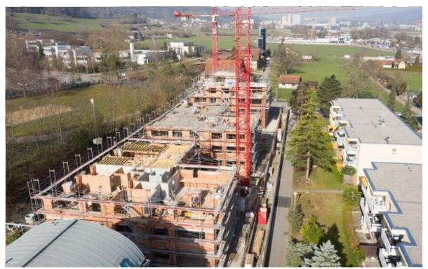
Auch bezüglich Fassade wurden keine Abstriche gemacht, damit die Aussenwände Feuchtigkeit aufnehmen und dank der Poren atmen können. Das isolierte Einsteinmauerwerk wirkt sich positiv auf das Wohnklima der 31 Neubauwohnungen im Rainacker aus.
