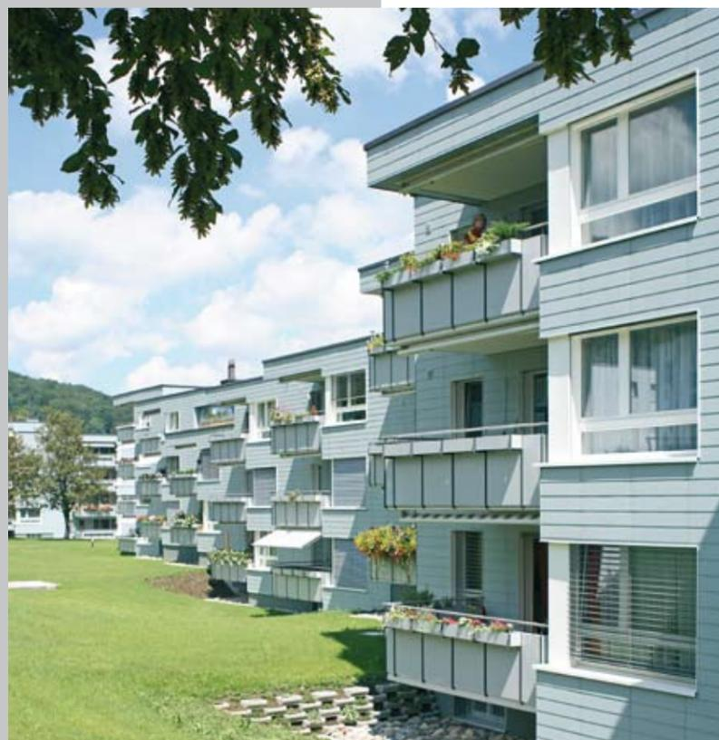
kombiniert werden. Eine zusätzliche Aufwertung erfuhr das optische Erscheinungsbild durch die leichten Metallgeländer mit integrierten Blumentöpfen, die die schwerfälligen Stürze und Brüstungen der Balkone ersetzen. Abgerundet wird die Sanierung durch eine Neugestaltung der Umgebung, die Schaffung neuer Spielplätze sowie eine neue Beleuchtung.
