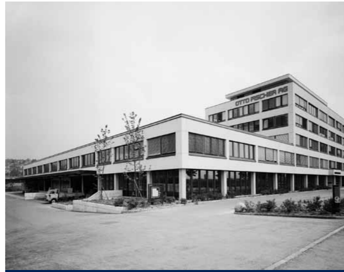
1977 Neubau Otto Fischer AG Zürich
