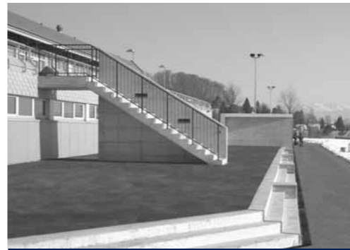
2002 Umbau Sporthalle Langacker Herrliberg
