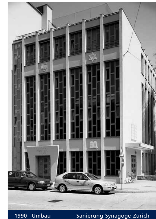
1990 Umbau Sanierung Synagoge Zürich
