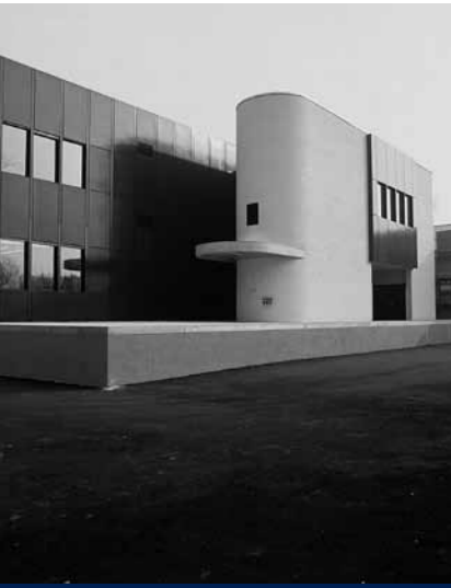
1969 Neubau Givaudan Dübendorf
