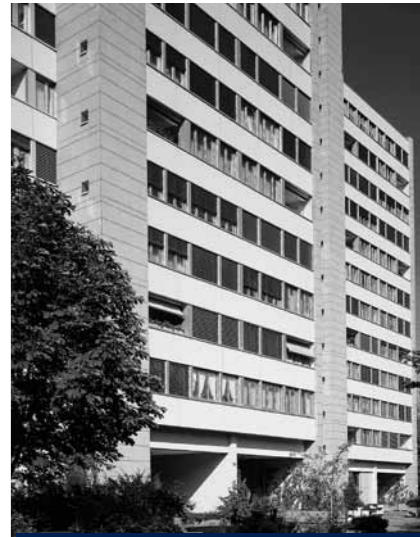
1982 Umbau Lochergut Zürich
