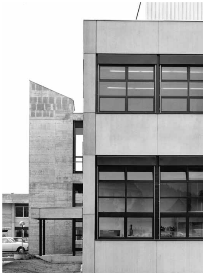
1968 Neubau Kaba Wetzikon 1. Etappe
