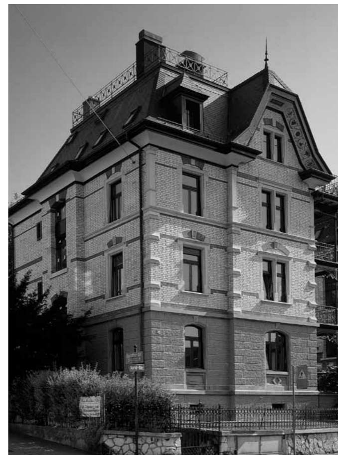
1987 Umbau MFH Zürich
