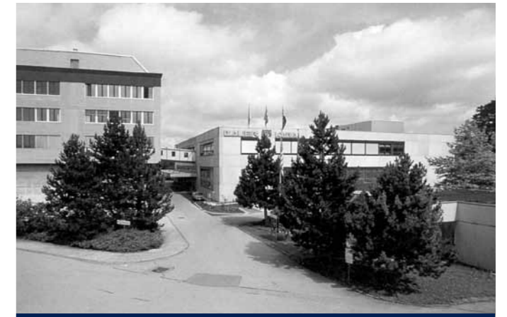
1979 Neubau Kaba Wetzikon 2. Etappe
