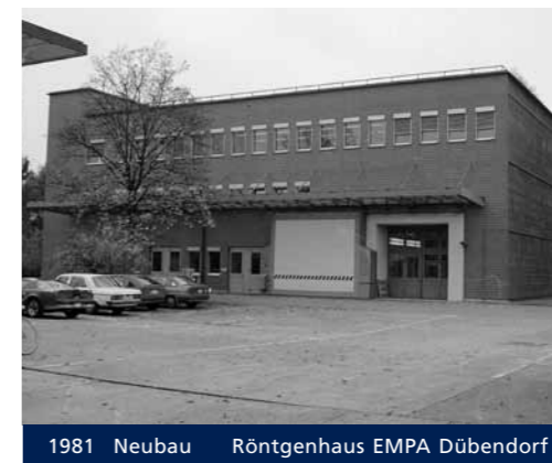
1981 Neubau Röntgenhaus EMPA Dübendorf
